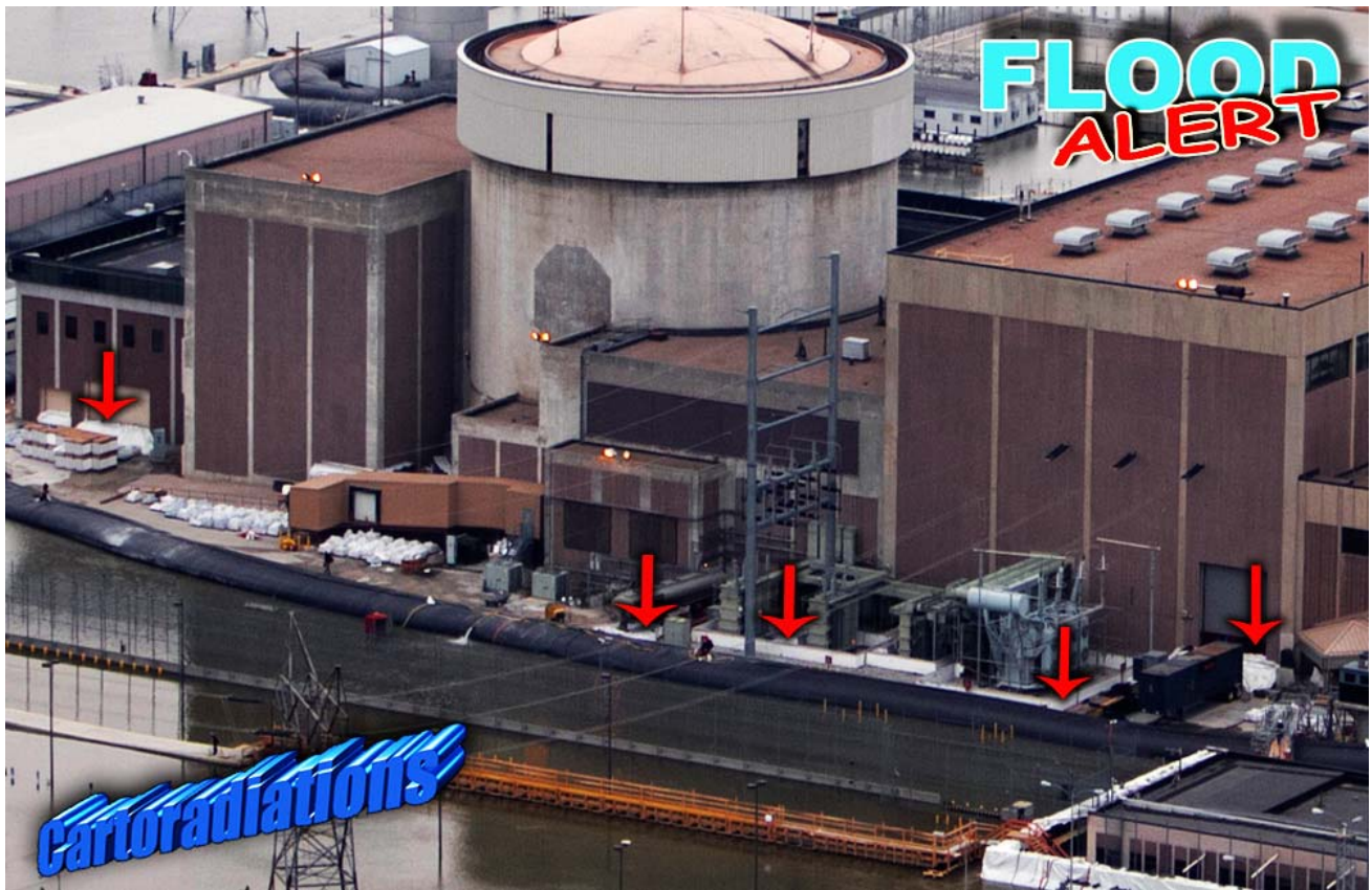
Fort Calhoun nuclear power plant encircled by a giant rubber barrier against the water and protection (sandbags). La centrale nucléaire de Fort Calhoun encerclée par une digue de protection en caoutchouc et des protections (sacs de sable).
