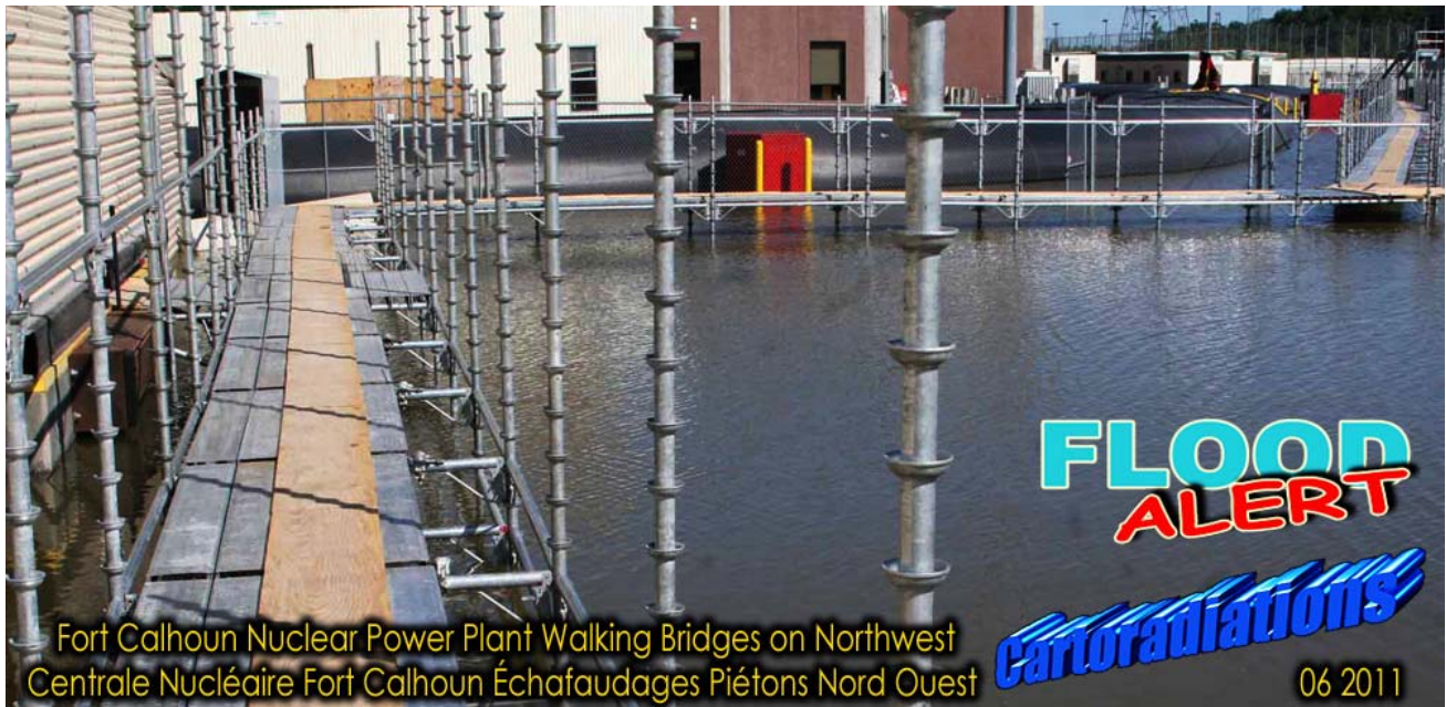
Fort Calhoun Nuclear Power Plant : Walking Bridges Northwest Centrale Nucléaire de Fort Calhoun : Zone Nord Ouest Echafaudages Piétons
