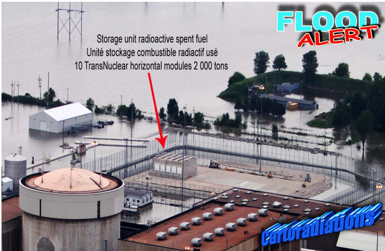
Fort Calhoun nuclear power plant: The spent fuel storage is in a modular concrete structure at ground level. Centrale nucléaire de Fort Calhoun : Le stockage du combustible usé est dans une structure modulaire en béton au niveau du sol.
