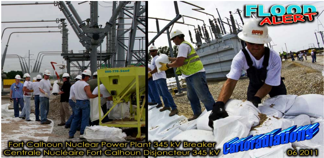
Fort Calhoun Nuclear Power Station : Breaker 345 kV Protection (sandbags!) Centrale Nucléaire de Fort Calhoun : Protections Disjoncteur 345 kV (sacs de sable !)
